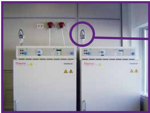
Controllo della temperatura su Stufe
