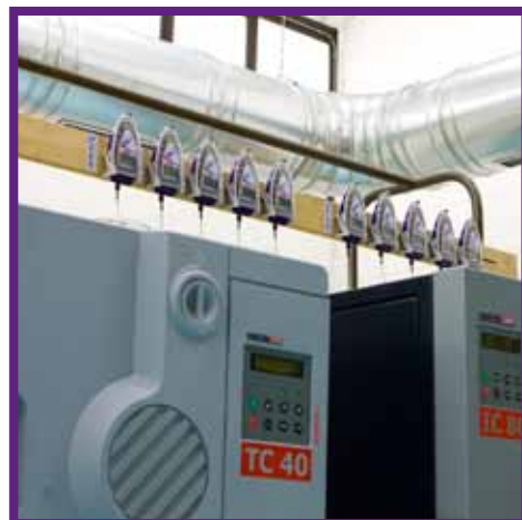
Controllo temperatura per mappatura stufe da laboratorio
